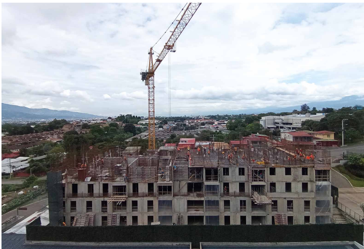
Construcción de la torre residencial A de Nueve84, en Aleste.
